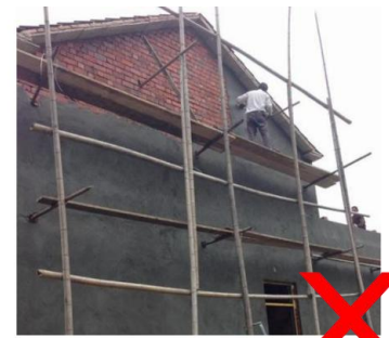
单排支撑，无剪刀撑
