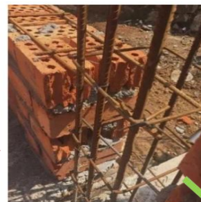
墙体设置拉结筋
