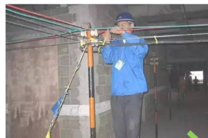
电缆线架空保护
