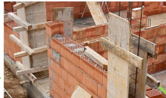
砌体结构，砖混结构应先砌墙后浇柱
