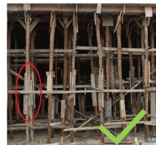
立杆接长采用对接夹板接头
